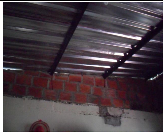
F.2: Correas y Cubierta instalados
