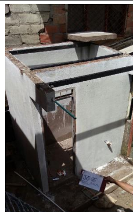
F.4: Pañetes, filos y placa Tanque Almacenamiento
