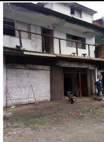
F.6: Fachada principal para proceso de pintura de Vinilo
