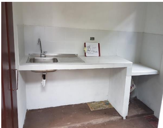
F.5: Mejoramiento terminado – perspectiva externa
