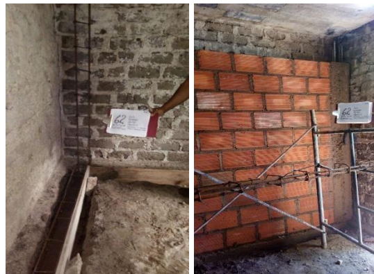
F.2: Excavación manual, Aceros, Columnas y Muros
