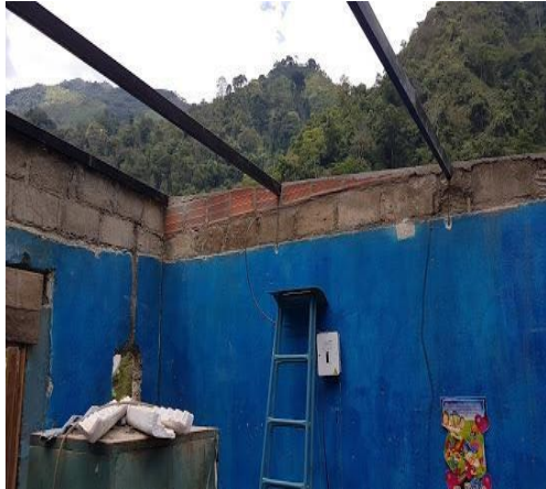
Foto No. 5: Inst. de pórticos y correas
