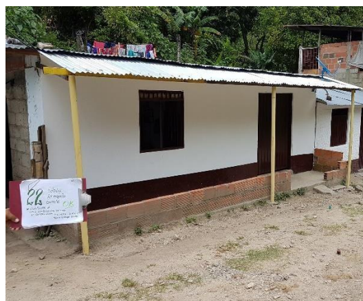
F.6: Fachada principal pintada y terminada
