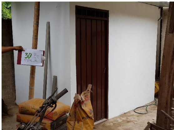
F.5: Vista externa del mejoramiento terminado
