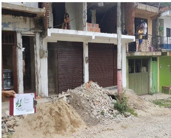
F.1: Fachada antes de intervenir
