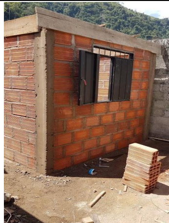
F.2: Proceso constructivo: Columnas, Muros y Viga aéreas
