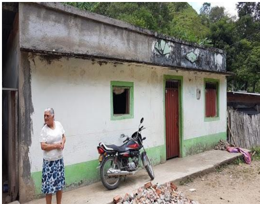
F.1: Fachada antes de intervenir
