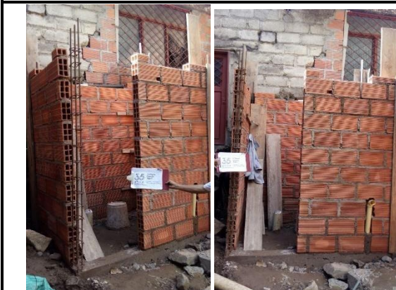
F.3: Viga de Cimentación, Castillos de acero y Muros
