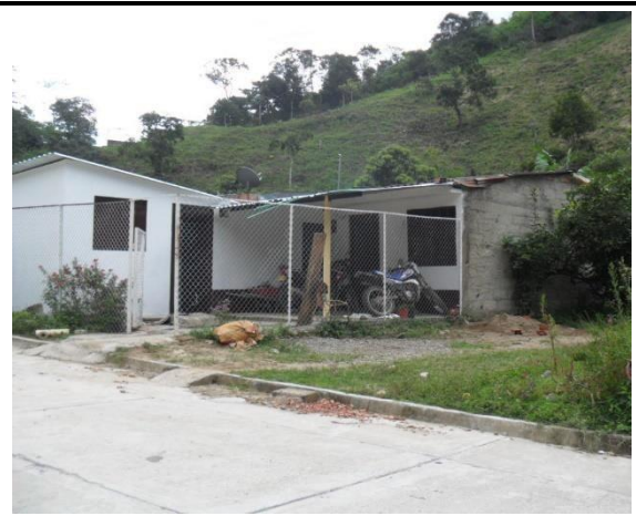
F.6: Fachada principal pintada y terminada
