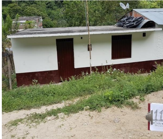
F.6: Fachada terminada
