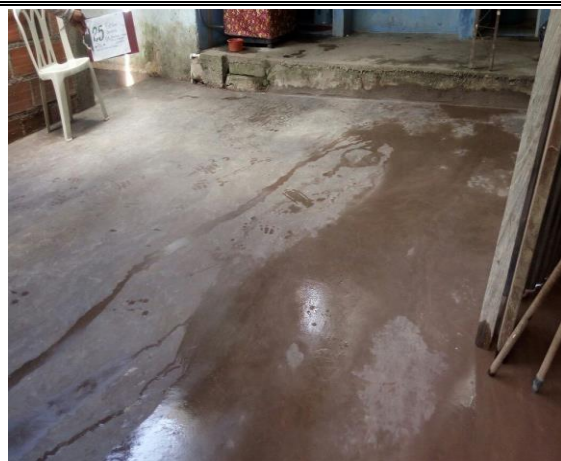
F.2: Ángulo del piso instalado (Construido)
