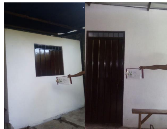
F 5: Instalación de Ventana y Puerta
