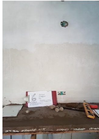
F.2: Ptos. Eléctricos y Mesón en Obra Negra
