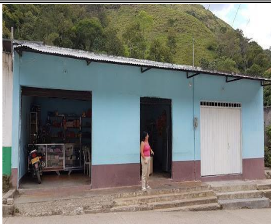
F.1: Fachada antes de intervenir
