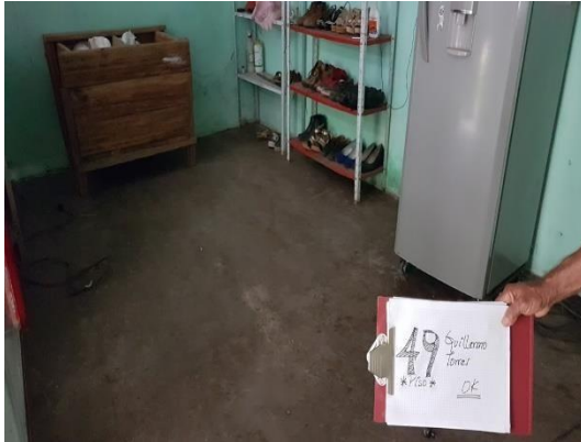
F.5: Ángulo del piso terminado
