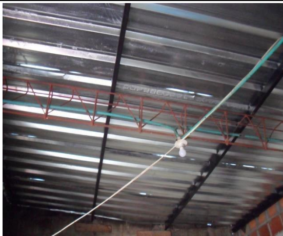
F.5: Correas y Cubierta instalados
