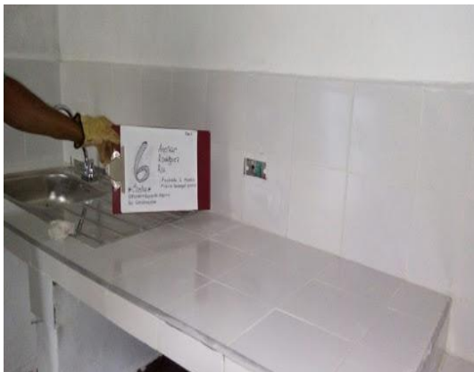
F.3: Enchape terminado
