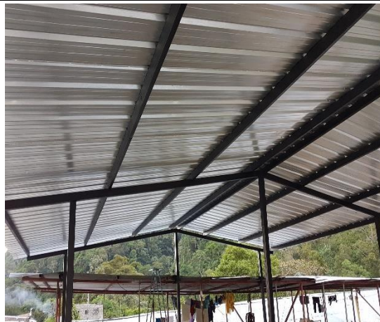
F.4: Pórticos, Correas y Cubierta
