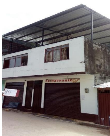
F.6: Fachada principal pintada y terminada
