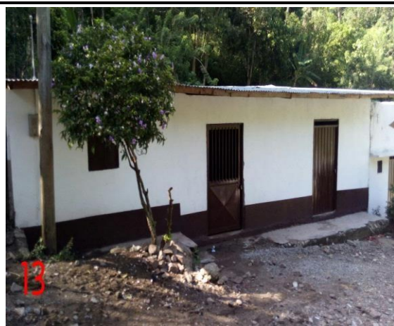
F.6: Pañete y aplicación de Vinilos para la Fachada principal
