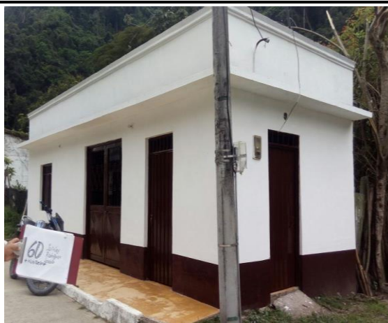
F.6: Fachada principal pintada y terminada
