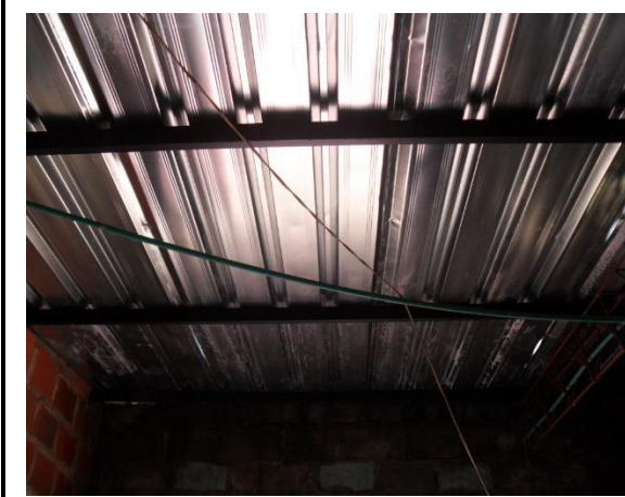
F.3: Correas y Cubierta instalados
