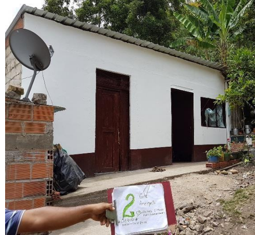
Foto No. 10: Fachada Terminada
