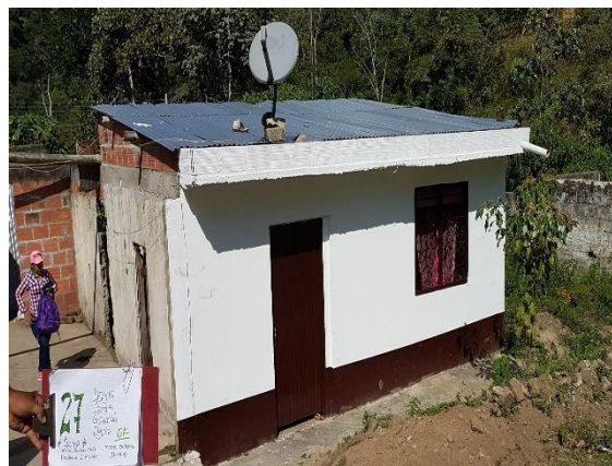
F.6: Fachada principal pintada y terminada
