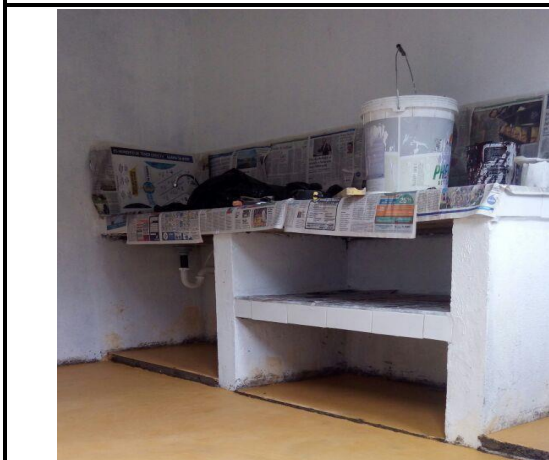
F.3: Puerta e interior de la habitación
