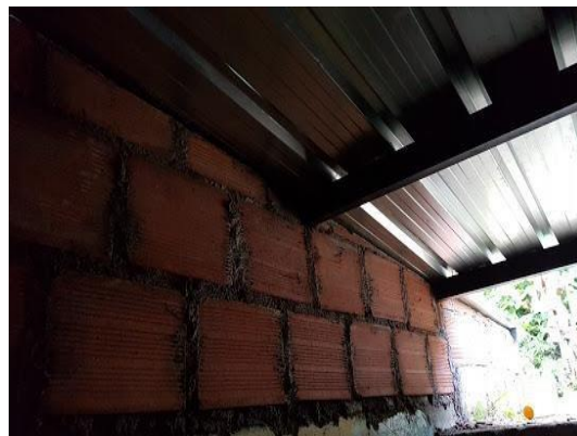
F.2: Cuchilla nueva para instalar las correas y conservar la pendiente existente
