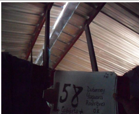
F.5: Parales sobre muro existente para alcanzar la altura de las cuchillas laterales
