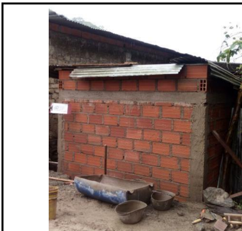
F.5: Columnas, viga aérea y muros
