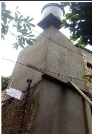
Foto No. 5: tanque, Pañetes y Filos
