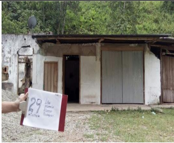
F.1: Fachada antes de intervenir
