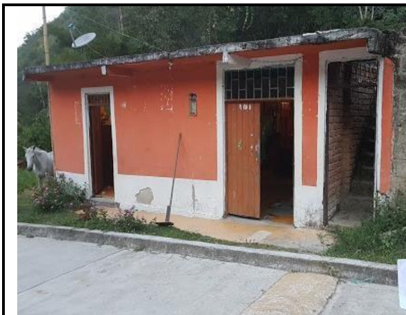
F.1: Fachada durante le proceso de pintura inicial
