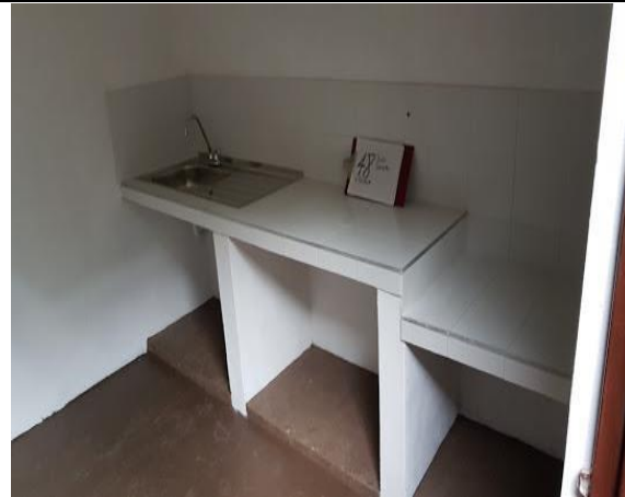
F.2: Mesón terminado, Lavadero, Enchape
