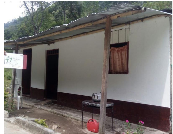
F.6: Fachada principal pintada y terminada
