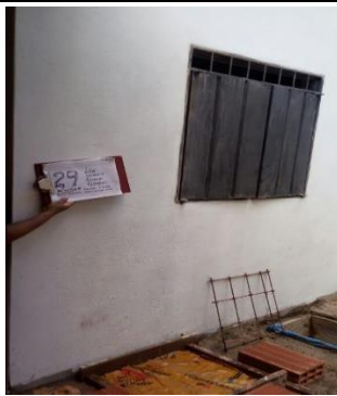
F.3: Ventana instalada, pañete + pintura vinilo
