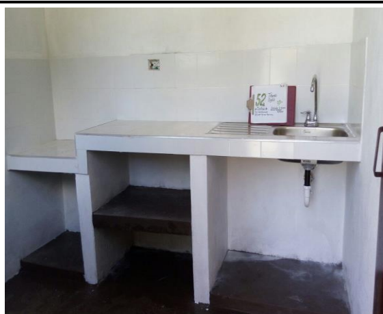
F.4: Mesón terminado, lavadero y enchape
