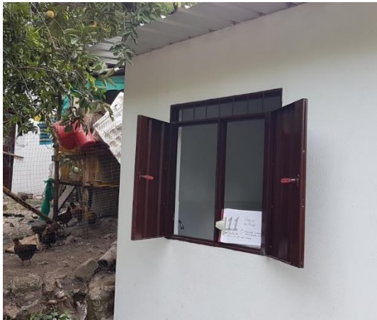
F.5: Puerta, Ventana, Pañetes, Pintura Vinilo y Alero
