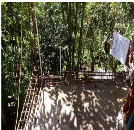
Foto No. 3: Viga de Cimentación, Muros y Viga Aérea
