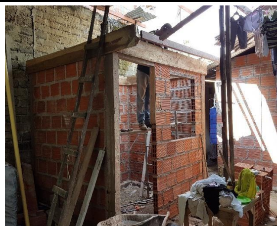
F.2: Columnas, Muros y Viga Aérea
