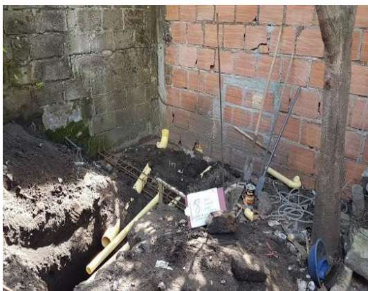
F.3: Obra Negra
