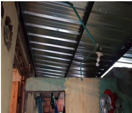
F.3: Instalación de Correas y Cubierta nueva
