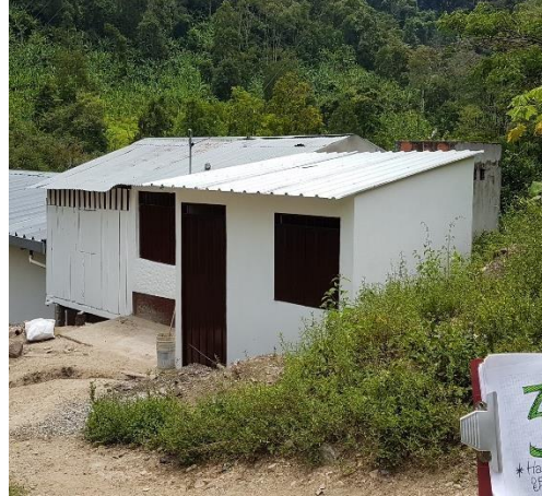
Foto No. 7: Falla terminada
