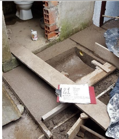
F.2: Localización, replanteo y excavación manual
