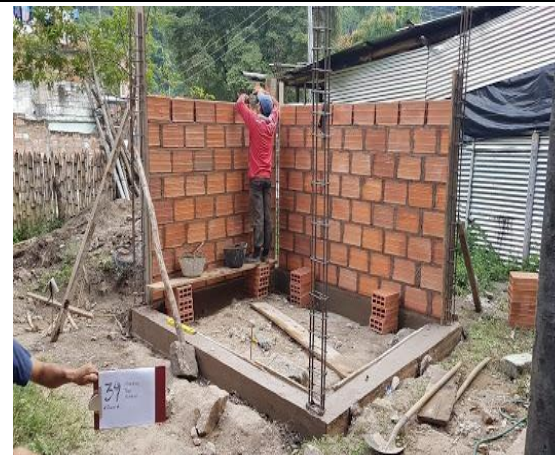
F.1: Fachada antes de intervenir
