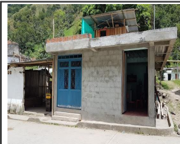
F.1: Fachada antes de intervenir
