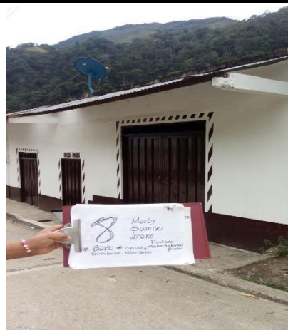
F.6: Fachada terminada
