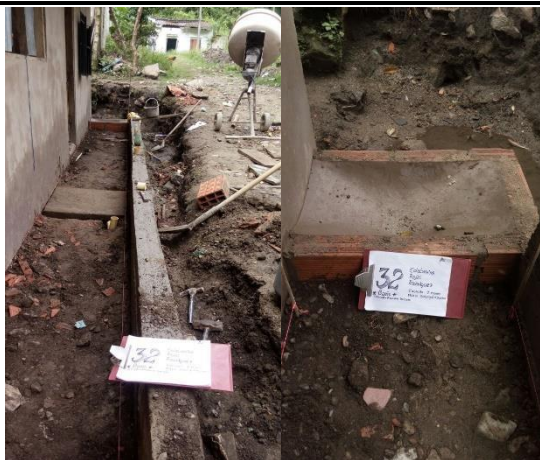
F.4: Pañetes, filos, Bordillo, Preparación de superficie para construcción de andén
