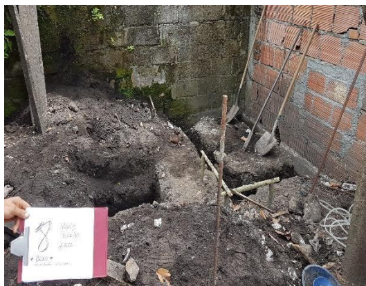
F.2: V/Cimentación, Castillo, Muros
