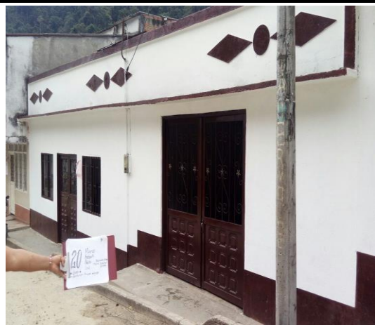
F.6: Fachada principal pintada y terminada
