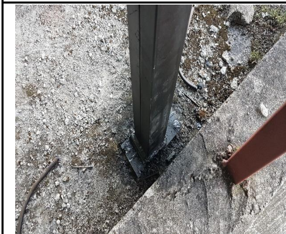
F.3: Sistema de anclaje platina + Ayazos y Paral doble
