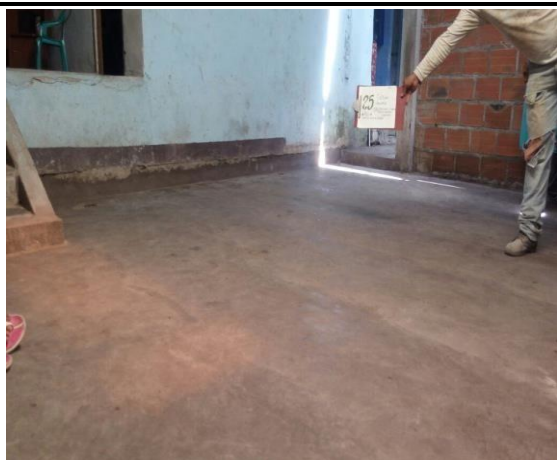
F.3: Otro ángulo del piso instalado (Construido)
