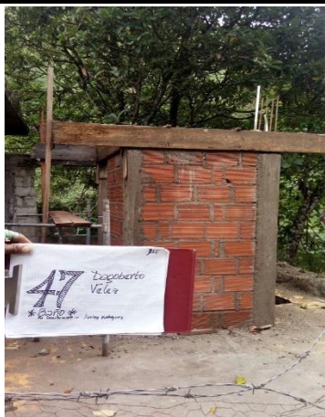
F.3: Obra negra proceso constructivo
