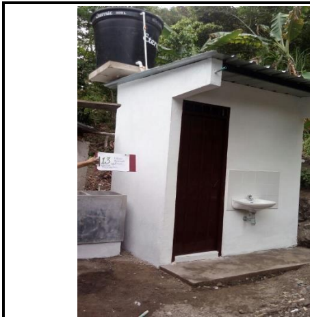
F.5: Puerta, Pañetes, Pintura Vinilo, Cubierta, Placa y Tanque Elevado
