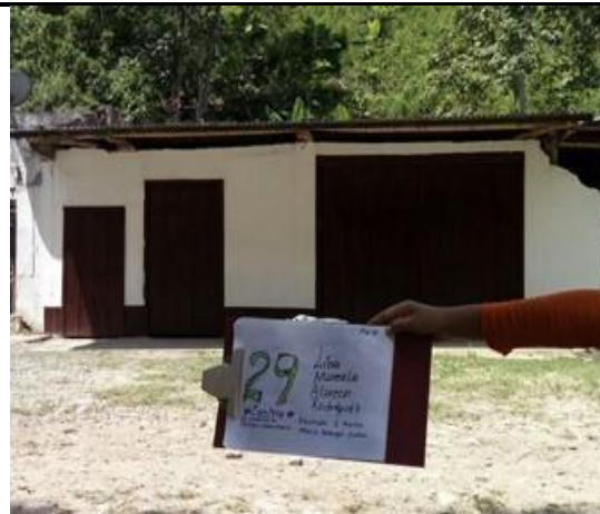
F.6: Fachada principal pintada y terminada
