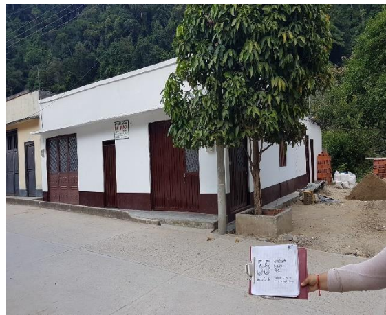
F.6: Fachada principal pintada y terminada
