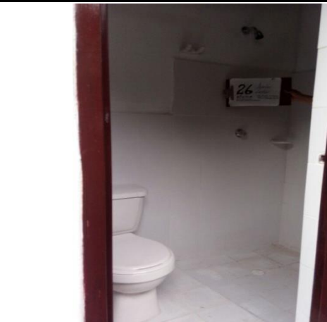
F.3: Instalación de: Sanitario, Ducha, Incrustaciones y Enchape
