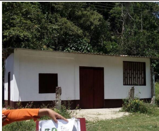
F.6: Fachada principal pintada y terminada
