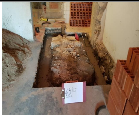
F.2: Excavación manual, Ccto Ciclopéo
