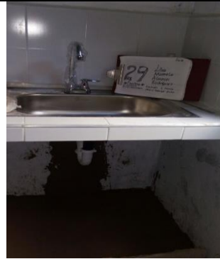
F.4: Mesón terminado, enchape y resanes de la instalación de aguas de lavado
