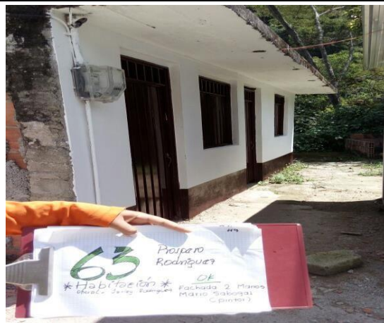
F.6: Fachada principal pintada y terminada
