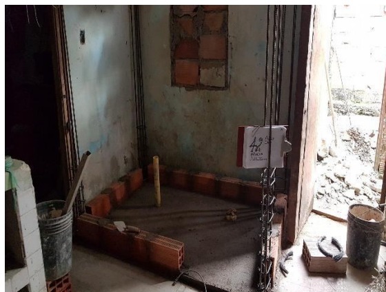
F.2: V/Cimentación, castillos de aceros e inicio de pega de Muros
