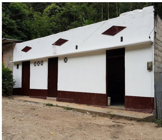
F.6: Fachada principal terminada
