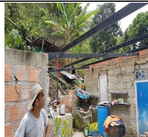
Foto No. 4: Inst. de pórticos y correas
