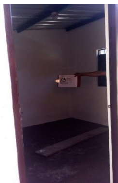
F.3: terminación interna: Correas, Cubierta, Ventana, pañetes y pintura vibilo
