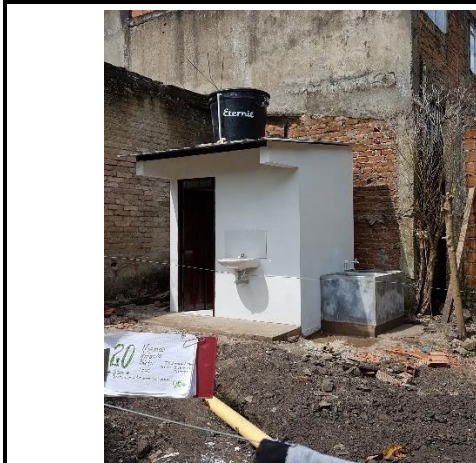
F.5: Perspectiva externa del mejoramiento terminado
