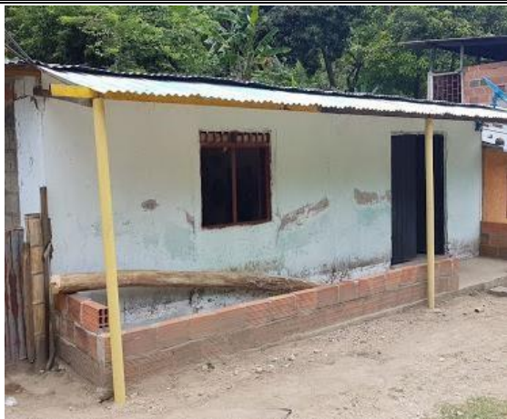
F.1: Fachada antes de intervenir
