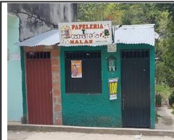
F.1: Fachada antes de intervenir
