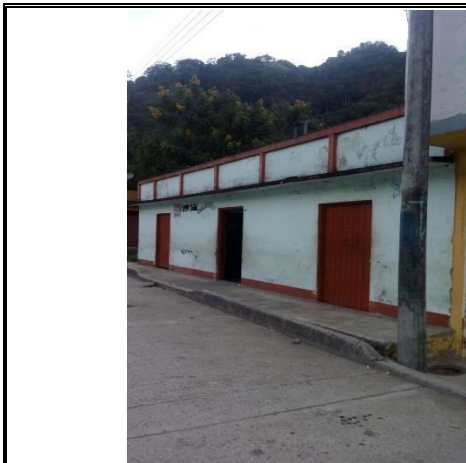
F.1: Fachada antes de intervenir
