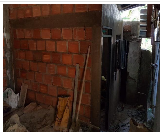
F.2: Columnas, Viga aérea y Muros
