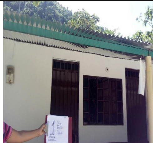
Foto No. 8: Unidad Terminada
