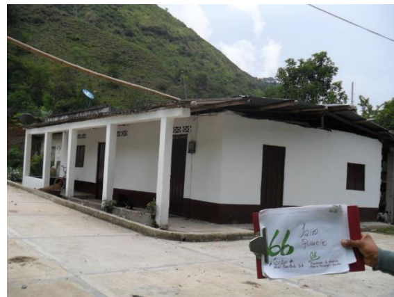
F 6: Fachada principal pintada y terminada
