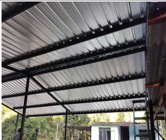
F.5: Pórticos, Correas y Cubierta
