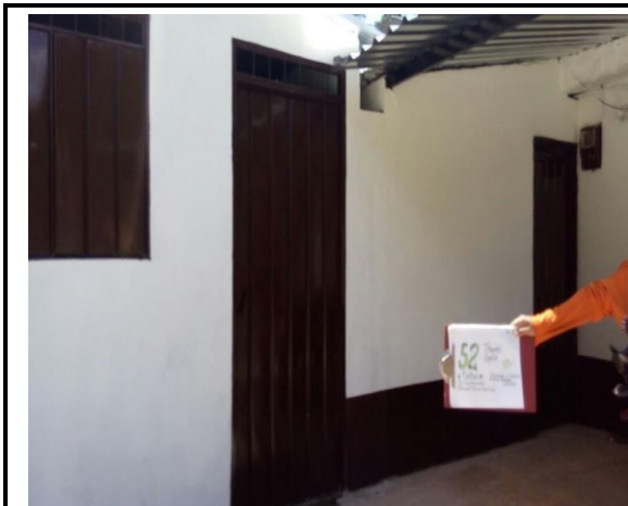
F.5: Puerta, Ventana y Canal de Aguas Lluvias
