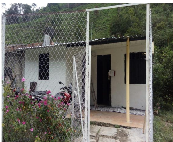
F.1: Fachada antes de intervenir
