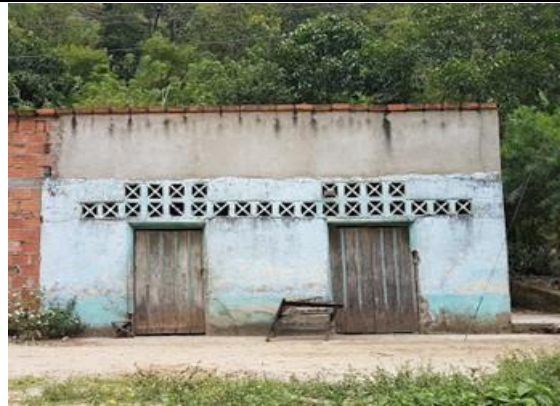
F.1: Fachada antes de intervenir
