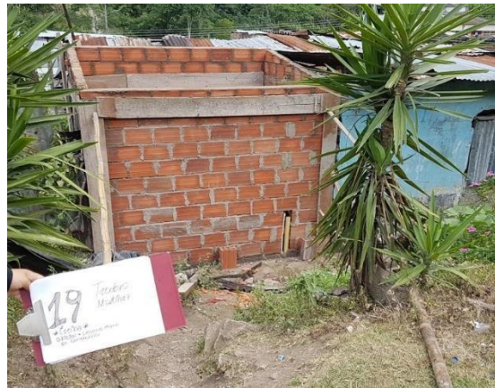
F.4: Columnas, Muros y Vigas superiores
