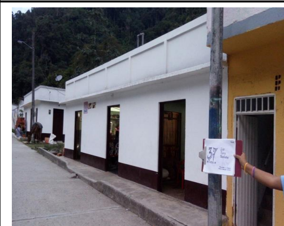
F.6: Fachada principal pintada y terminada
