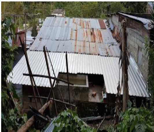
F.5: Vista aérea de la cubierta como quedo instalada
