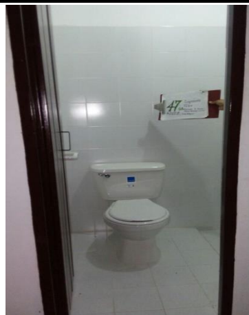
F.4: Puerta, Sanitario, Incrustaciones y Enchape
