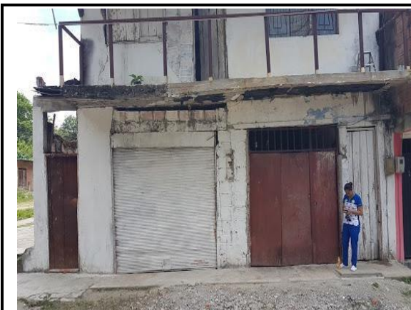
F.1: Fachada antes de intervenir
