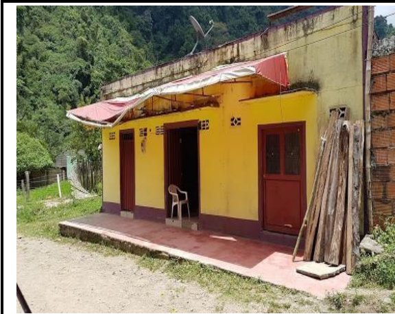
F.1: Fachada antes de intervenir
