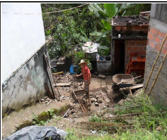
F.2: Viga Cimentación, Castillos de acero
