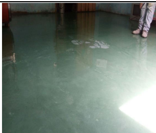
F.4: Ángulo del piso terminado
