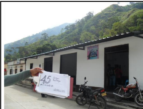
F.5: Panorámica de la Cubierta
