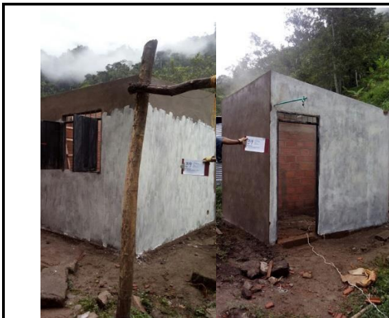
F.3: Puerta e interior de la habitación
