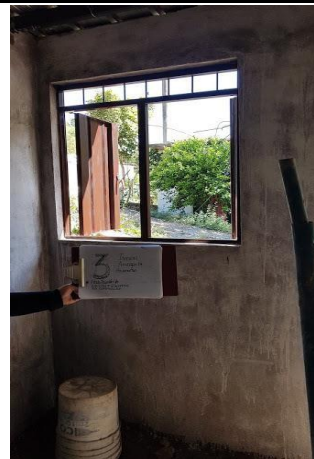
Foto No. 4: Venta parte interna
