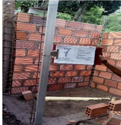
F.2: V/Cimentación, Castillo, Muros
