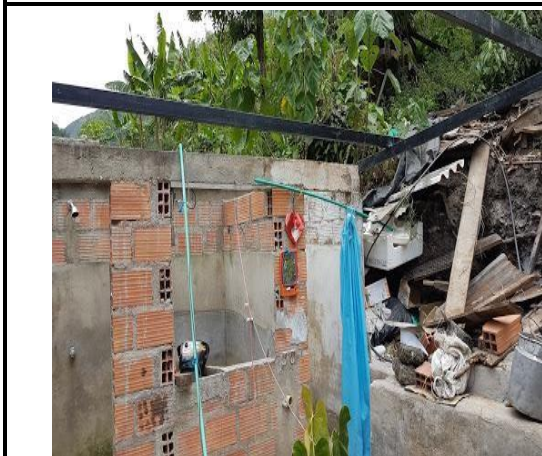
Foto No. 3: Inst. de pórticos y correas
