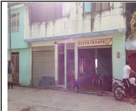
F.1: Fachada antes de intervenir
