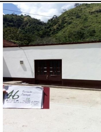
F.6: Fachada principal pintada y terminada
