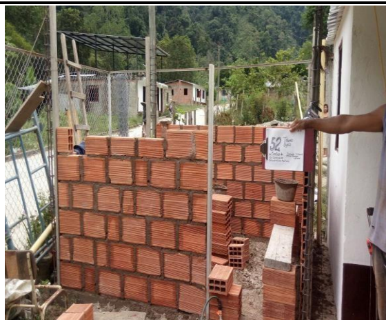
F.2: Muros, Castillos de acero
