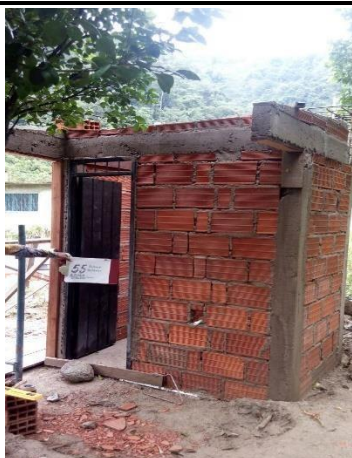
F.3: Viga Cimentación, Columnas, Muros, Viga Aéreas y Puerta
