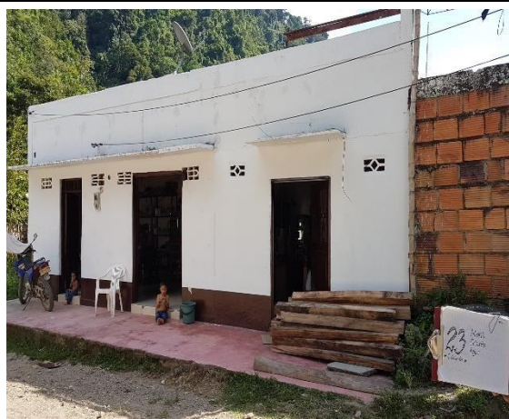
F.6: Fachada principal pintada y terminada
