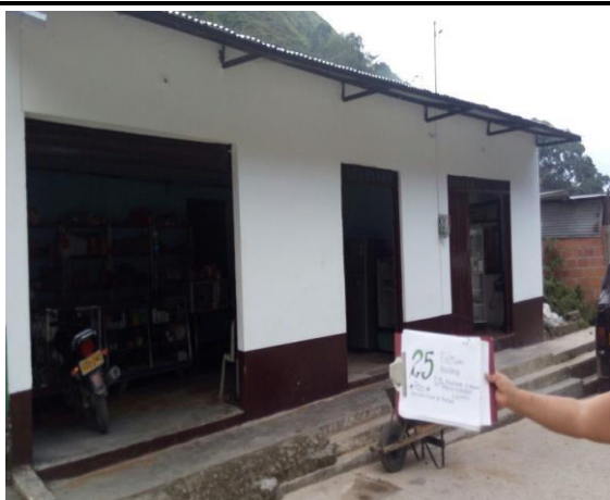
F.6: Fachada principal pintada y terminada
