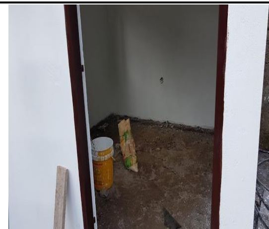
F.3: Puerta e interior de la habitación
