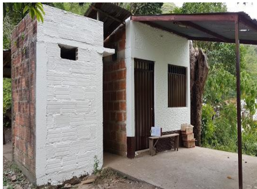
F.6: Fachada principal terminada
