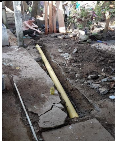
F 2: Conexiones sanitarias e hidráulicas
