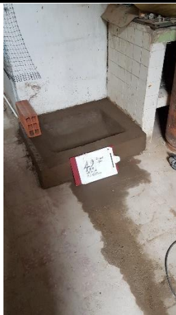
F.3: Muros, Vano para puerta – Caja de Inspección
