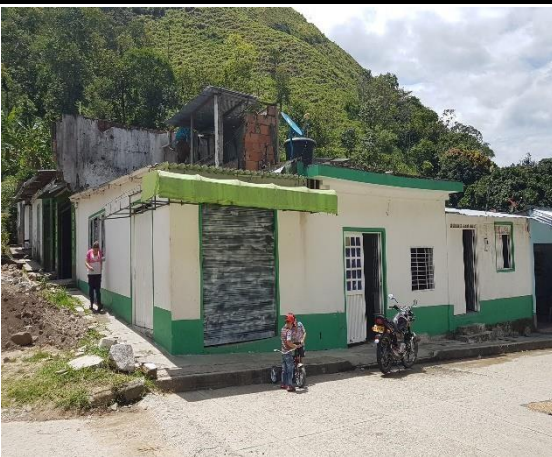
F.1: Fachada antes de intervenir
