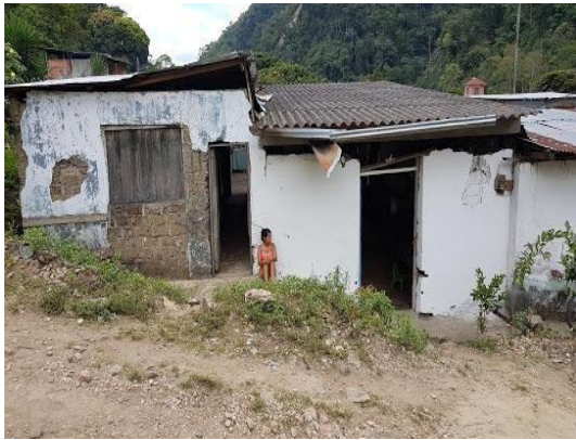
F.1: Fachada antes de intervenir
