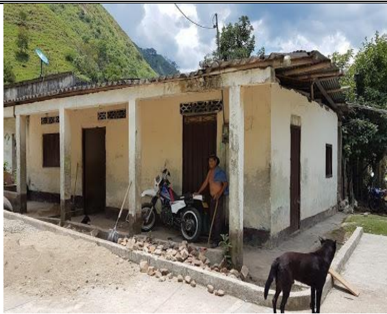
F 1: Fachada antes de intervenir
