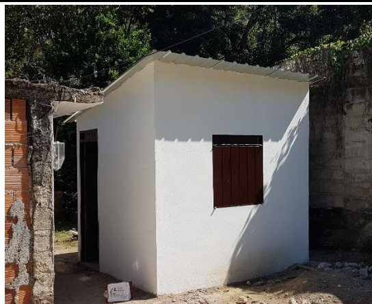
F.4: Perspectiva externa del mejoramiento terminado
