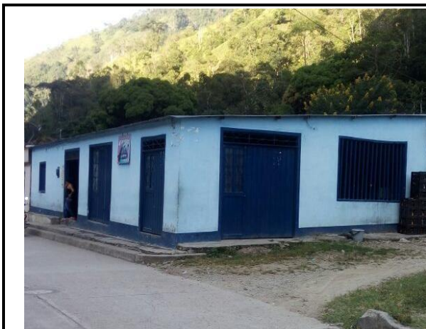
F.1: Fachada antes de intervenir
