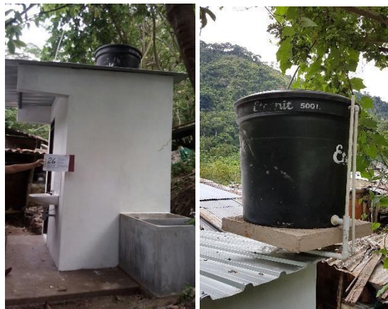
F.5: Vista general de la Unidad Sanitaria y Tanque de almacenamiento
