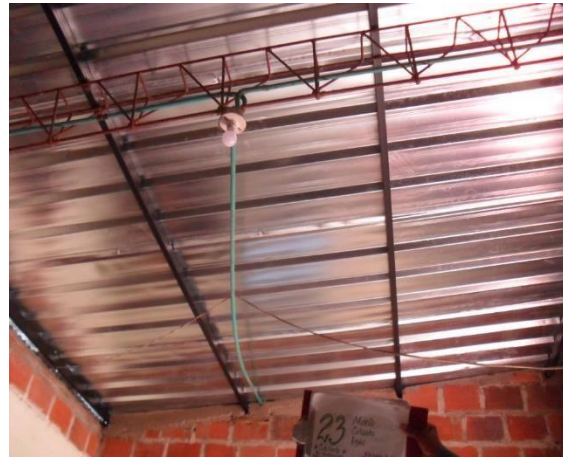
F.4: Correas y Cubierta instalados
