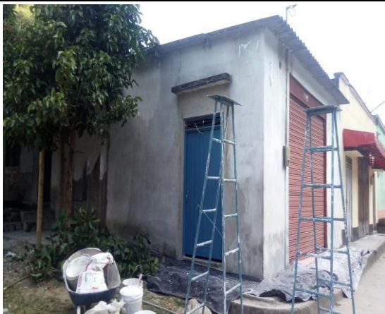
F.1: Fachada antes de intervenir
