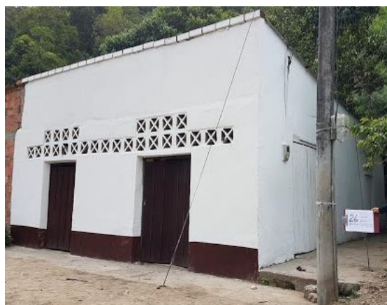
F.6: Fachada principal pintada y terminada
