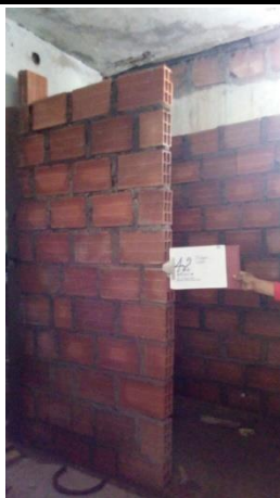
F.3: Muros, Vano para puerta – Caja de Inspección
