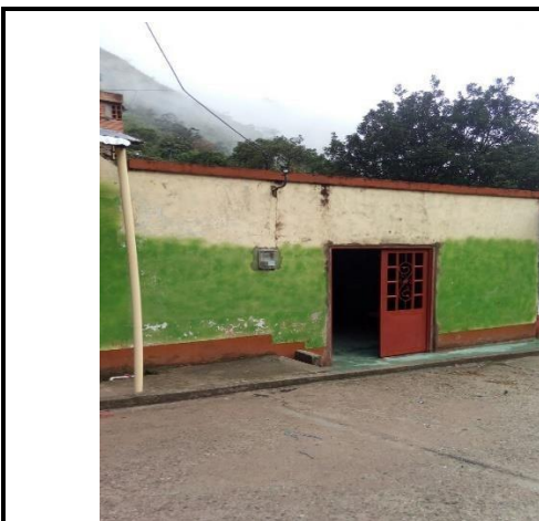
F.1: Fachada antes de intervenir
