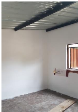
F.3: terminación interna: Correas, Cubierta, Ventana, pañetes y pintura vibilo
