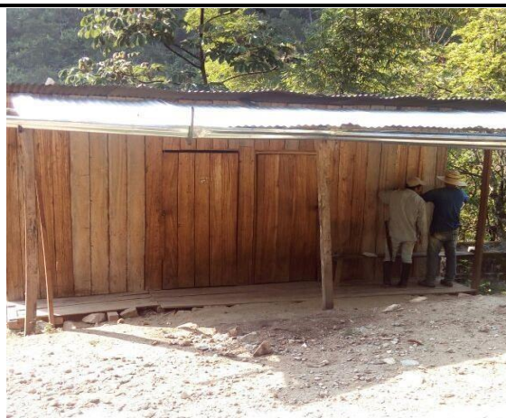
F.1: Fachada antes de intervenir
