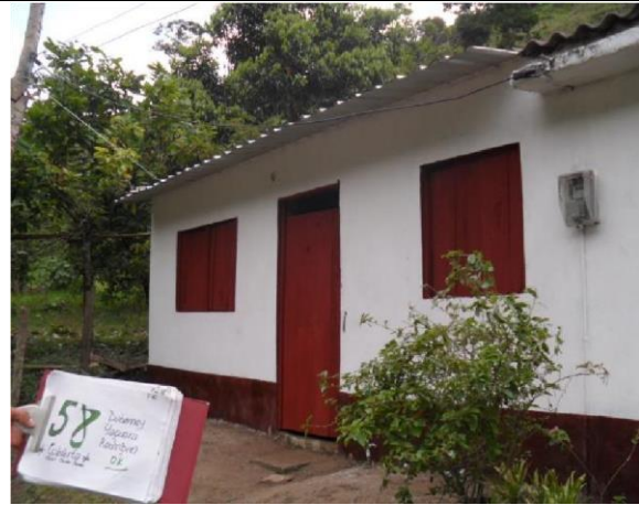
F.6: Fachada principal pintada y terminada
