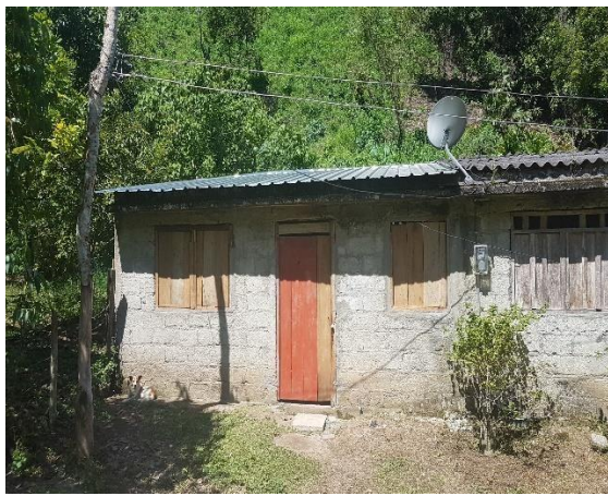
F.1: Fachada antes de intervenir
