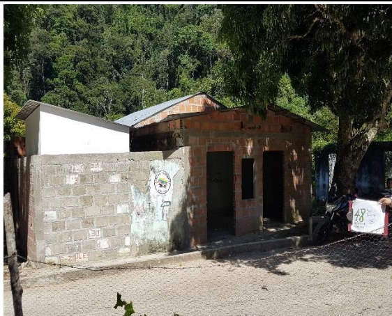
F.1: Fachada antes de intervenir
