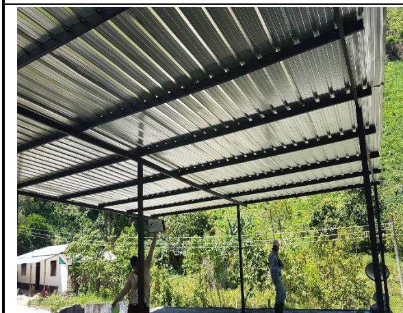
F.3: Parales, Pórtico, Correos e instalación de la Cubierta
