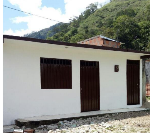
F.6: Fachada principal pintada y terminada
