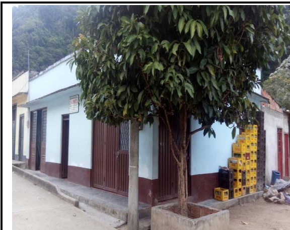
F.1: Fachada antes de intervenir
