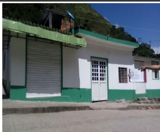
F.6: Fachada principal pintada y terminada
