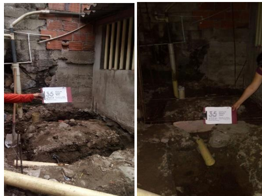
F.2: Excavación manual e Instalaciones Sanitarias
