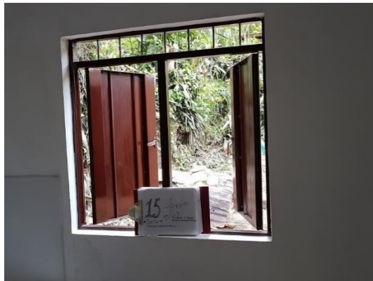
F.2: Instalación de ventana cara interna, pañetes, filos y aplicación de vinilo sobre paredes cosntruidas
