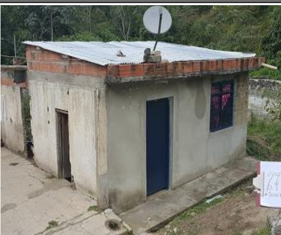
F.1: Fachada antes de intervenir
