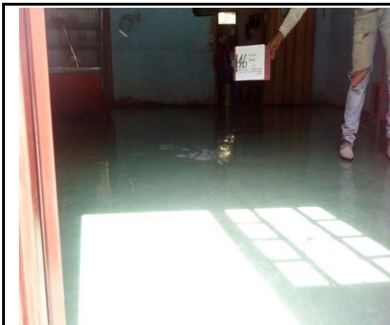
F.3: Ángulo del piso terminado
