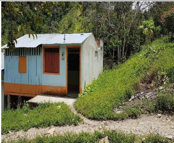
Foto No. 1: Fachada antes de ser intervenida
