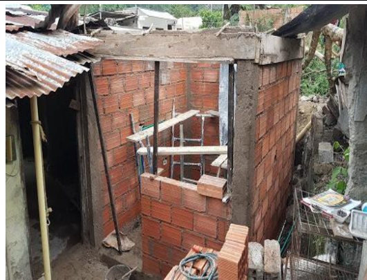
F.2: V/Cimentación, Castillo, Muros, V/Aéreas
