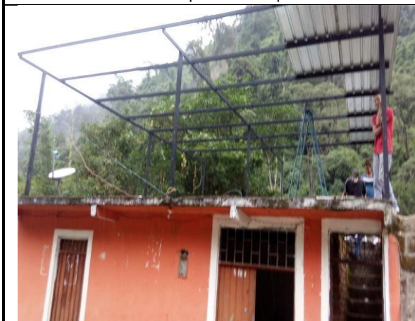
F.3: Parales, Pórtico, Correos e instalación de la Cubierta
