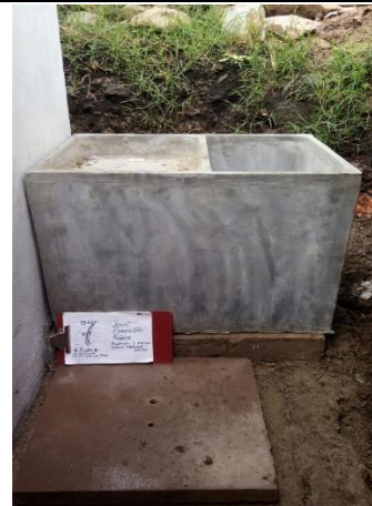
F.4: Caja de Inspección y Lavadero
