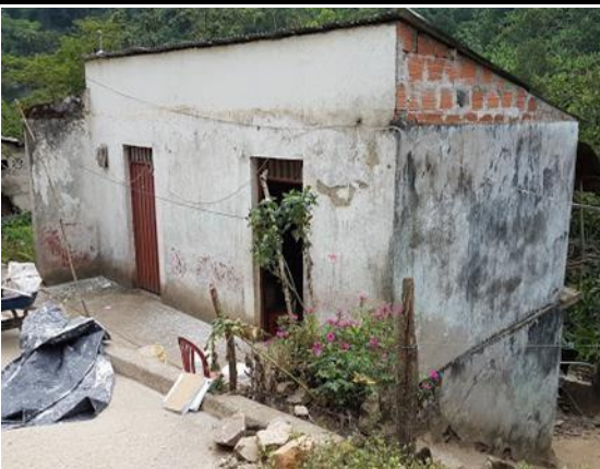
F.1: Fachada antes de intervenir
