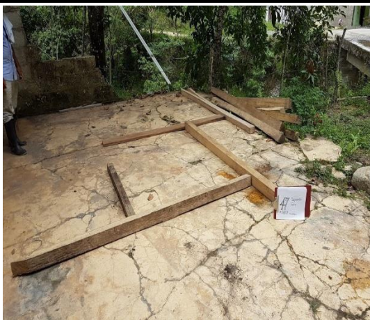
F.1: Área donde se construirá la Unidad Sanitaria
