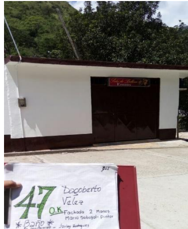
F.6: Fachada principal pintada y terminada
