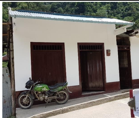
F.6: Fachada terminada
