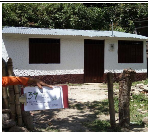
F.6: Fachada principal pintada y terminada
