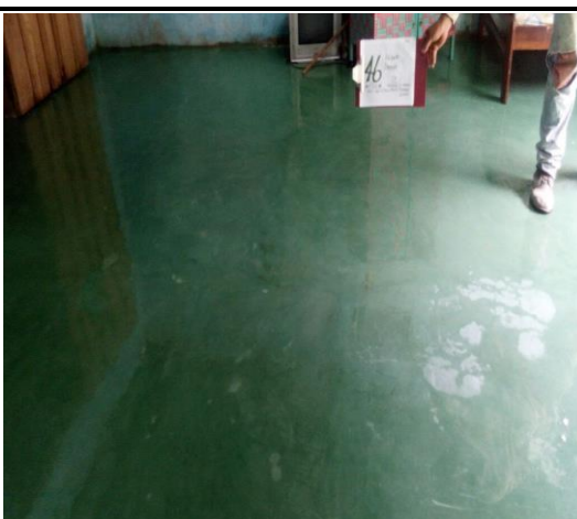
F.2: Ángulo del piso terminado
